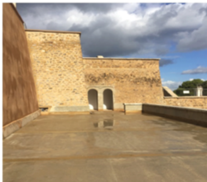
RECONSTRUCTION DU PLANCHER
