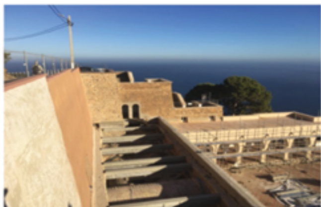
DÉMOLITION DU PLANCHER
